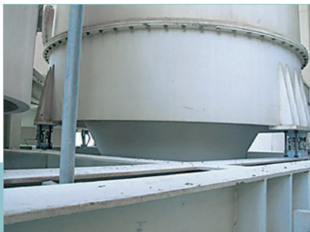
精密压式称重传感器PR 6201专门为筒仓、罐和液体容器的称重而设计
